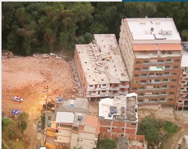
Prédios desabaram na Muzema em abril desse ano deixando 24 pessoas mortas
