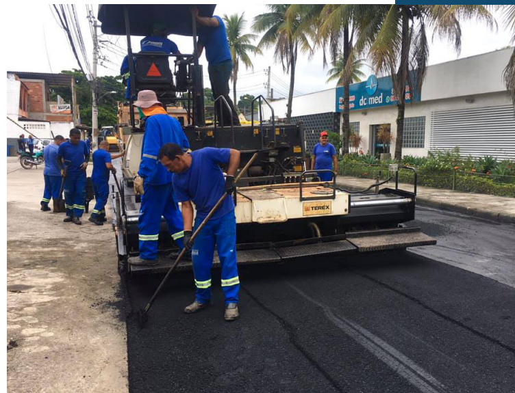
O segundo distrito recebeu obras de macrodrenagem
