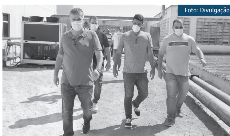
O prefeito Washington Reis visita obras que estão em andamento no município
