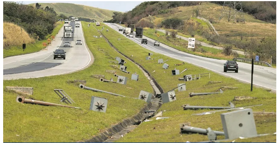
Na altura de Seropédica, dezenas de postes caídos, já retirados pela concessionária que assumiu o Arco Metropolitano. Rodovia está às escuras e sem previsão para novo sistema de iluminação — Foto: Márcia Foletto
