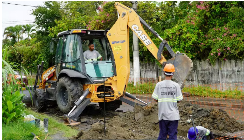
Cerca de 700 quilômetros de redes e mais de 60 estações de bombeamento serão construídas durante os dois anos de obras em Queimados e Japeri — Foto: Divulgação/Águas do Rio
